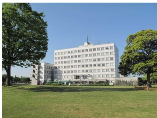
写真:久留米リサーチ・パーク （福岡バイオインキュベーションセンター） 福岡バイオバレープロジェクトの活動拠点 となる研究開発施設 （写真提供:久留米市）
