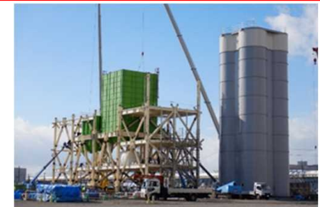
建設中の中部飼料(株)工場
