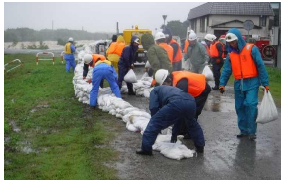
積み土のう工（平成30年7月豪雨）
