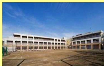
学校を改修して整備した事例
