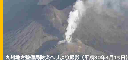
九州地方整備局防災ヘリより撮影(平成30年4月19日)
