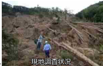
現地調査状況
