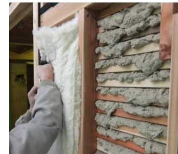
○ 土壁で外断熱とした施工のイメージ
