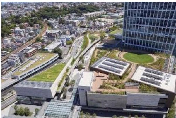
屋上緑化、みどりの広場、ビオドープ、遊歩道等の整備
