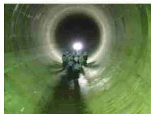
雨水貯留管(東京都)
