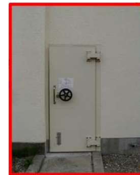
出入口扉の水密化
