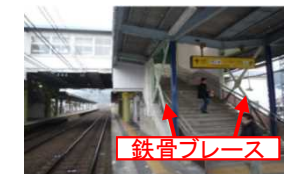
鉄骨ブレースによる駅の耐震補強
