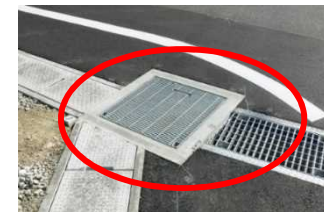
道路上の排水施設
