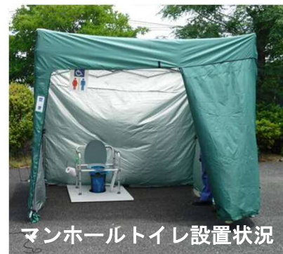
今回の豪雨において、避難所にマンホールトイレを設置した事例（広島県三原市）
