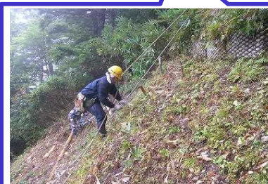
斜面上の測量作業
