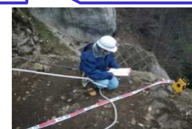
高所斜面上の臨場検査
