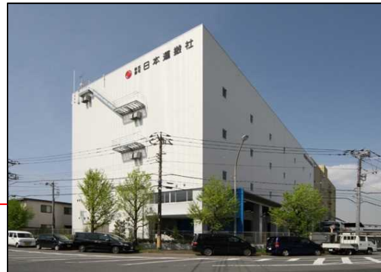
名称：日本運搬社 本牧倉庫(2016.11竣工) 住所：横浜市中区かもめ町21 敷地面積：3,000㎡ 延床面積：6,000㎡ 備考：地上5階建て、自動車部品等を取扱
