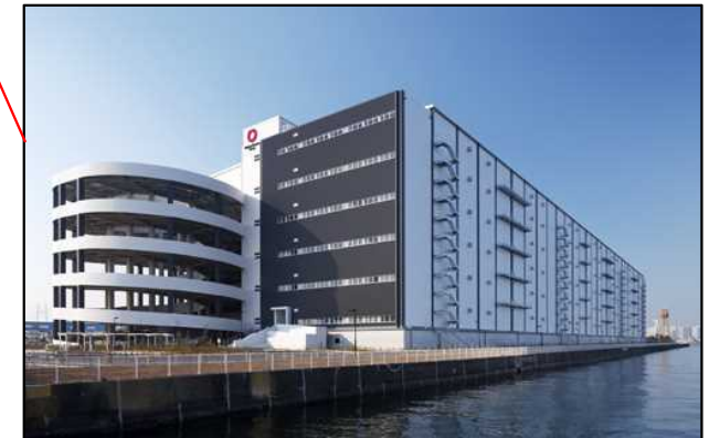
名称：大和ハウス工業 DPL横浜大黒(2014.3竣工) 住所：横浜市鶴見区大黒町 敷地面積：61,379㎡ 延床面積：118,158㎡ 備考：マルチテナント型物流センター、ランプウェイ
