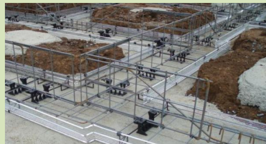
[住宅用基礎の配筋状況]
