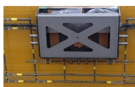
図 1 点検口補強システム
