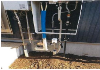
給湯器廻り (左) 給湯循環 ポンプユニット(QE-1) (右) 給湯器下 配管加工 施工中
