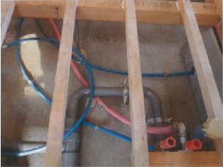
床下給湯配管 洗面化粧台用給湯管 施工中
