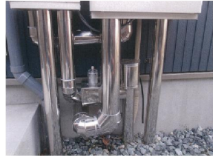
給湯器廻り 手前1階給湯器 給湯循環ポンプユニット (QE-1)廻り 対応パワーマシ 仕上げ完了
