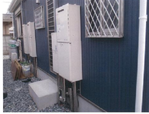
給湯器廻り 2階2台給湯器 (2階1床住居用) 手前1階給湯器 給湯循環ポンプユニット (QE-1) 施工完了
