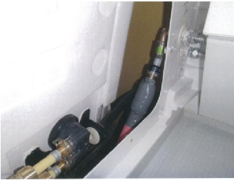
ユニットバス 配管接続用点検口 パワーマシ配管廻り 施工完了
