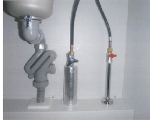
洗面化粧台下 給湯止水栓廻り 施工完了
