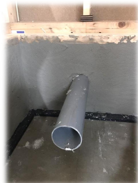
ベタ基礎内側の断熱モルタル施工
