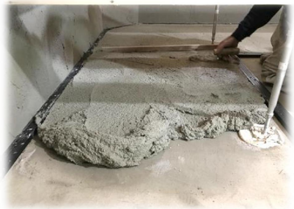
ベタ基礎床の断熱モルタル施工
