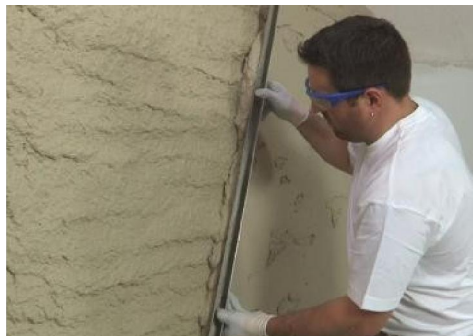
湿式吹付け工法イメージ
