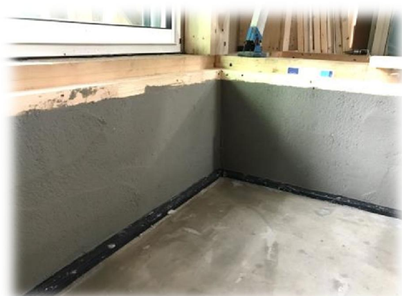
ベタ基礎内側の断熱モルタル施工
