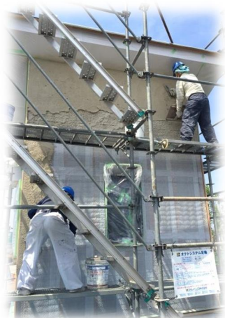
従来の左官工事 金コテ塗り施工
