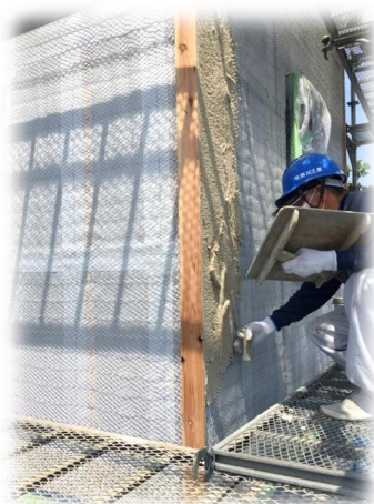
従来の左官工事 金コテ塗り施工
