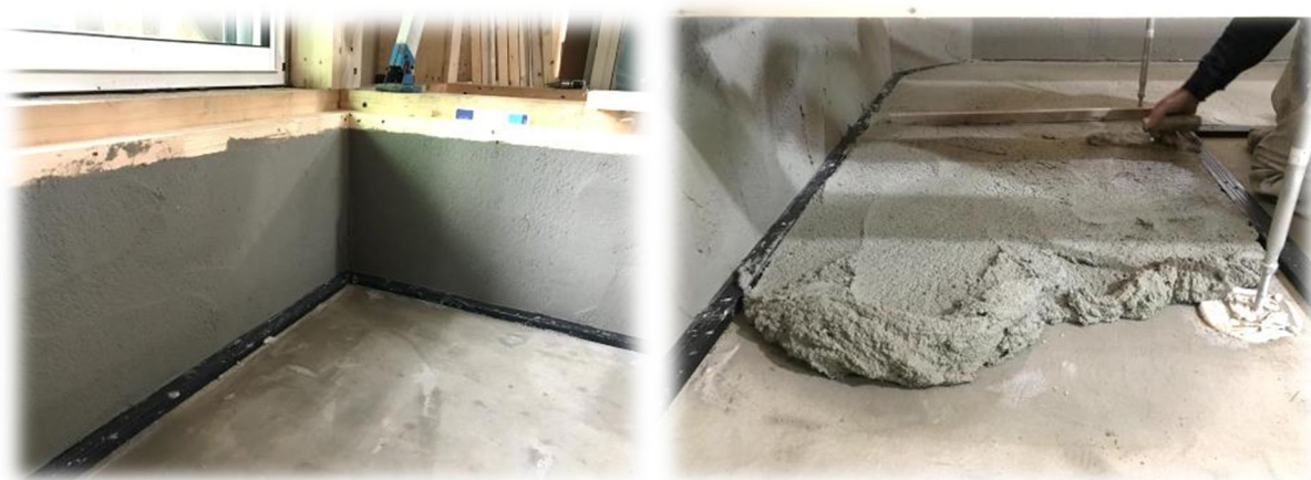
住宅ベタ基礎の内側と床面を断熱モルタルで施工
