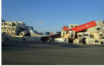
写真 2.3.1 コンテナの倒壊の状況
