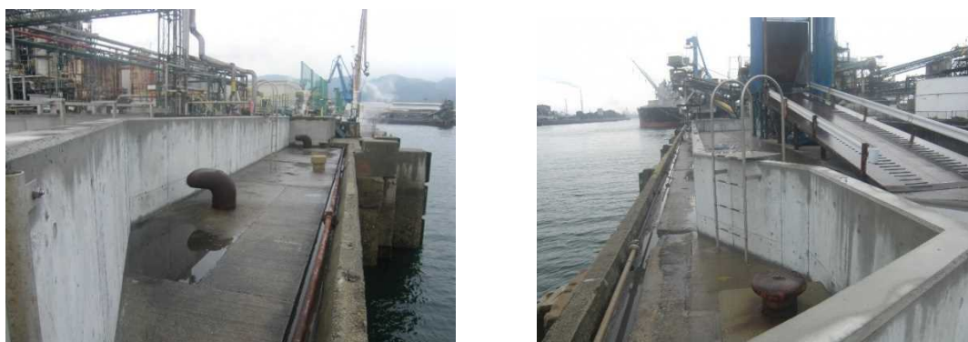
写真 3.5.2 岸壁水際部分の嵩上げ
