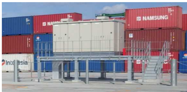
写真 3.1.1 電気設備を嵩上げ（津波対策）
