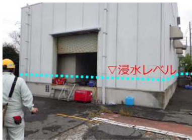
写真 2.2.1 受電所の浸水 (床上約 30cm)
