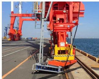
写真 2.5.1 ケーブルリールの落下状況
