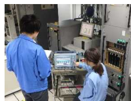
(航空保安施設点検実施状況)
