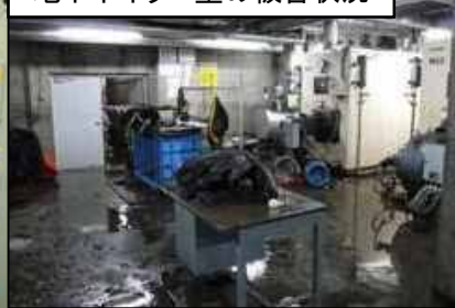
地下ボイラー室の被害状況
