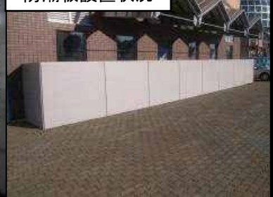
防潮板設置状況
