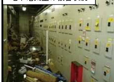
地下電気室の被害状況
