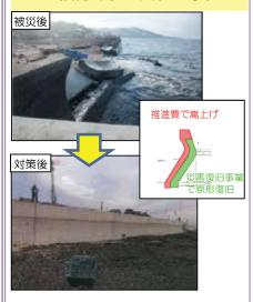
被災した護岸を災害復旧事業による原形復旧にあわせて、推進費により嵩上げを実施。
