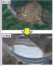
災害復旧事業の対象とならない風化・ 劣化による崖崩れで通行止めが発生した ため、推進費により法面対策を実施。
