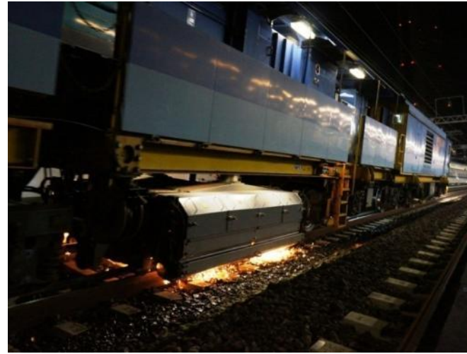
レール削正の様子
