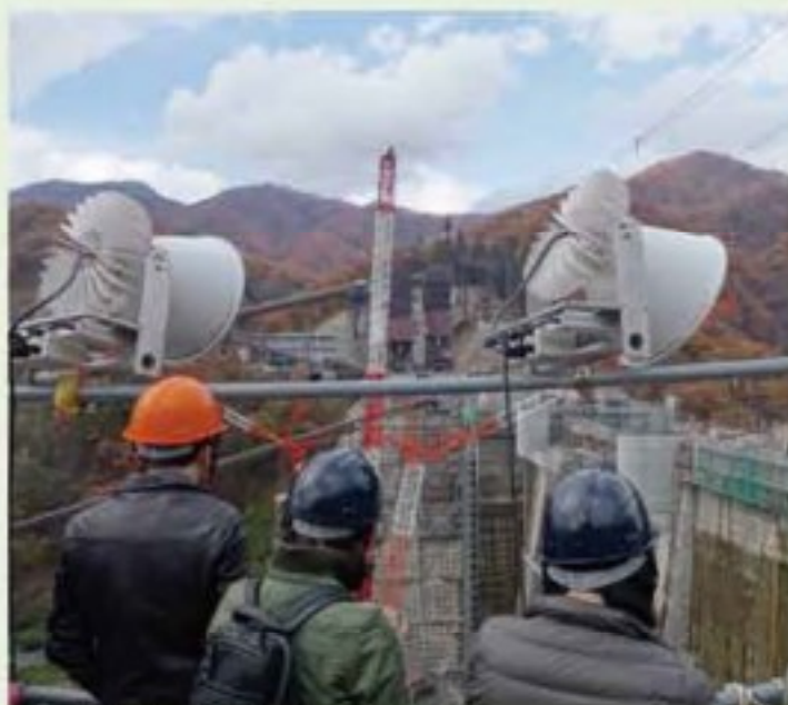
ダム建設中の多彩な見学ツアーで魅力UP (ハッ場ダム・群馬県)
