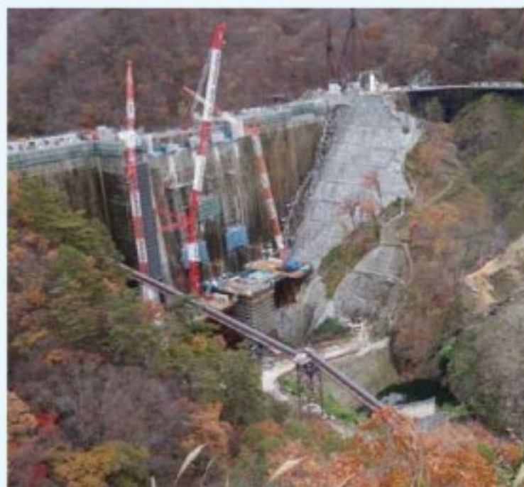
「やんば見放台」からダム工事の全景を望む
