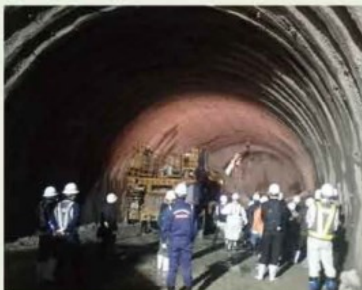
複数のインフラを組み合わせるツアーの魅力UP (国道185号 休山トンネル・広島県)
