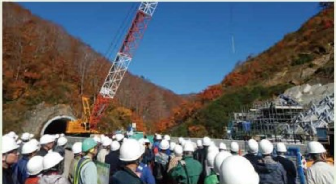
工事現場見学と周辺資源の組み合わせで魅力UP (国道289号 八十里越・新潟県・福島県)
