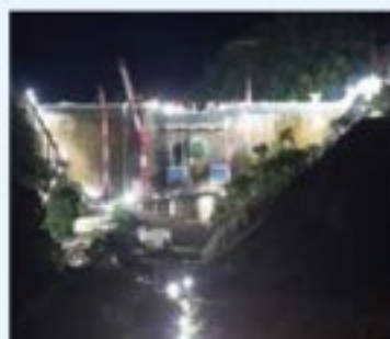
ハッ場ダム夜間工事
