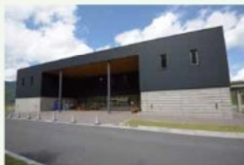
トイレがあるダム管理棟
