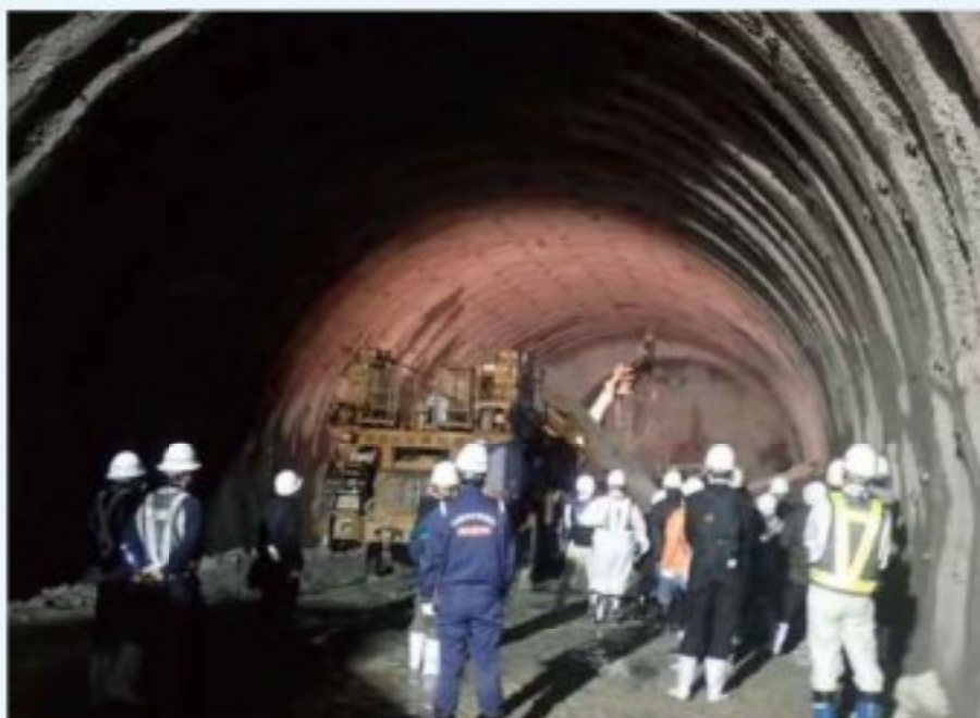
工事中の休山トンネルの見学
