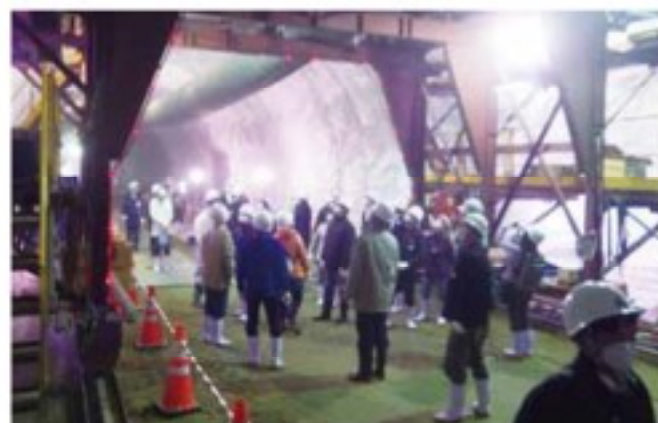
コンクリート打設前で防水シートを貼った段階
