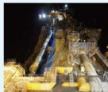
横瀬川ダム夜間工事
