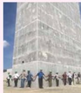
工事中の(仮称)気仙沼湾横断橋の橋脚の大きさを体感
