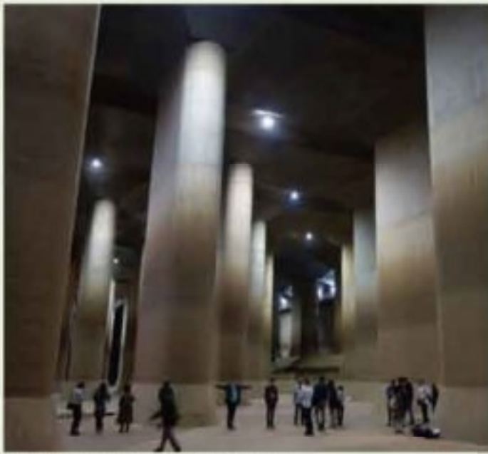
民間運営見学システムで受け入れ枠を拡大 (首都圏外郭放水路・埼玉県)
