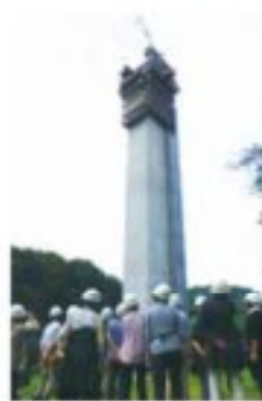
工事中の橋梁の見学
