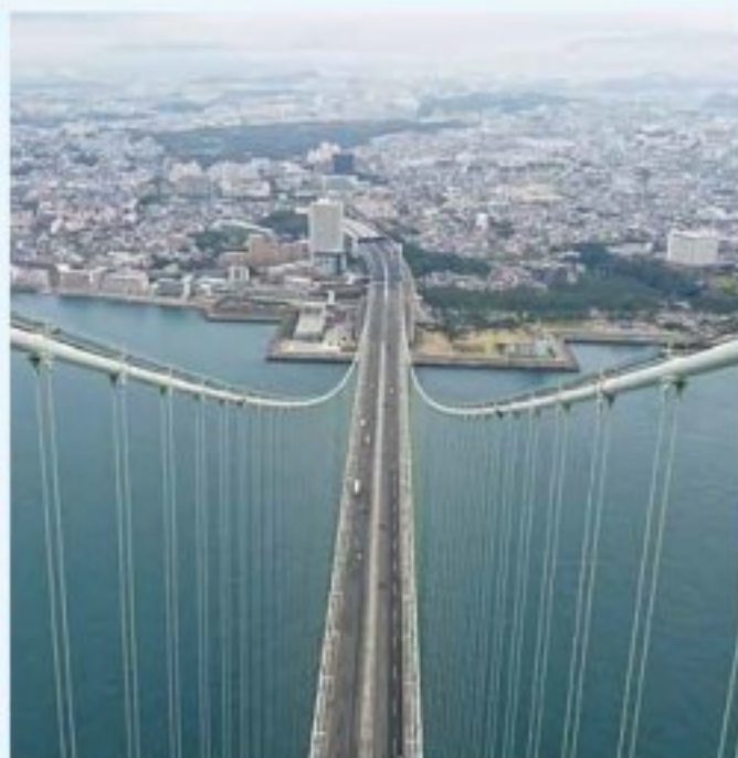
主塔の上からの眺め（神戸市側をのぞむ）
