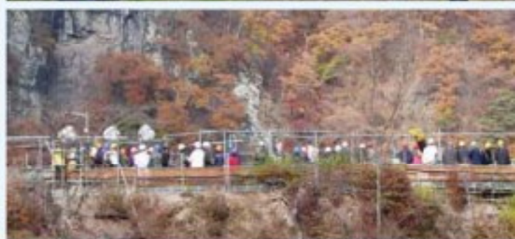
(上) 左岸のやんば見放台(展望台)へのアプローチ路は舗装され手すりもあり高齢者の方でも行きやすい (下) 右岸のツアー用の展望台は仮設で整備されている
