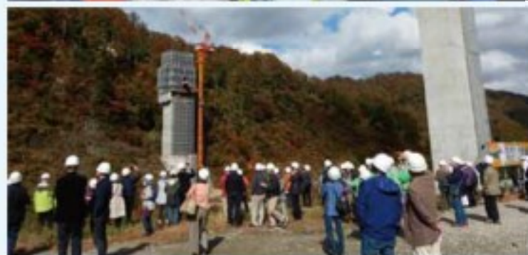
峠のトンネルや橋梁の工事現場を見ることができ
