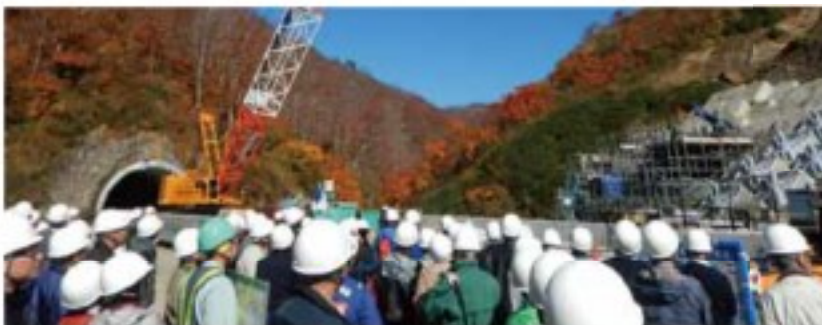
新潟県と福島県を結ぶ 国道289号線の工事見学会 工事期間を縫って見学会を開催し、年間1,000人程度を受け入れている。工事見学だけでなく周辺観光資源も巡るバスツアーで構成している。
