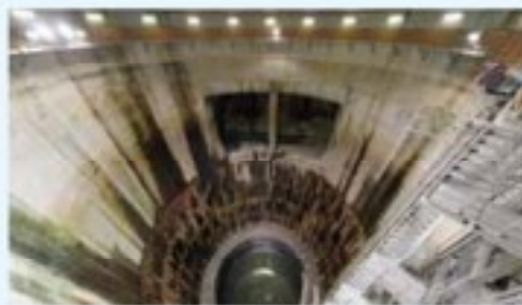
公開が始まった立坑
