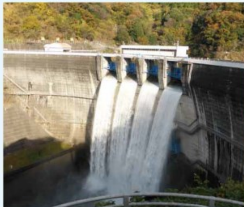
クレストゲートからの点検放流
