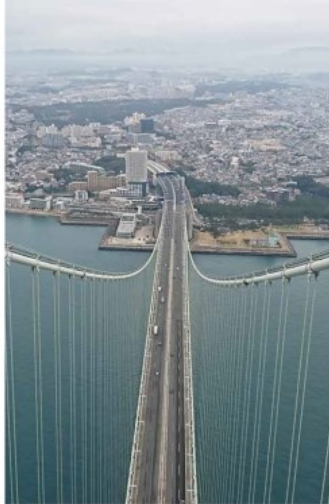
明石海峡大橋
