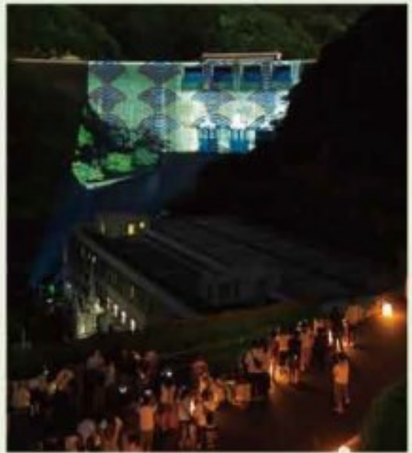
宇治市街地に近いダムを観光資源として活用 (天ヶ瀬ダム・京都府)
