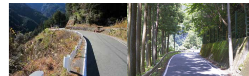
写真2 幅員の不足する国道152号
