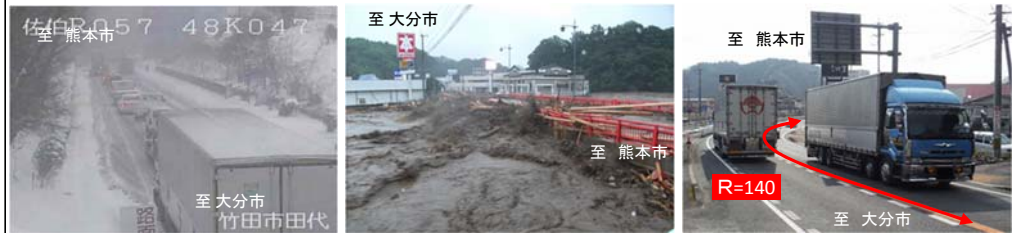
▲H262積雪時スタック発生状況(写真①) ▲H24.7九州北部豪雨被災状況(写真②) ▲平面線形が厳しい箇所(写真③)
