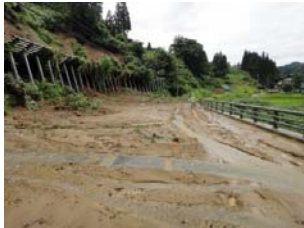
写真1 新潟・福島豪雨被災状況(H23.7)
