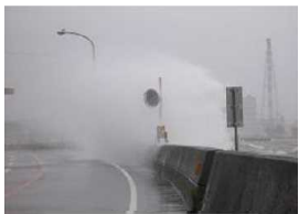
写真 越波状況
