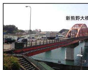
【写真②】新熊野大橋の渋滞状況
