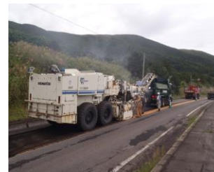
【舗装路面の切削作業状況】
