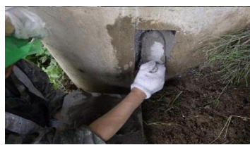
【断面修復状況】
