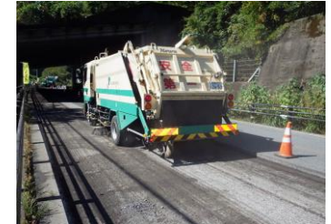
【切削廢材の清掃作業状況】
