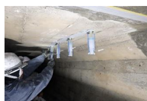
【補修材の注入状況】
