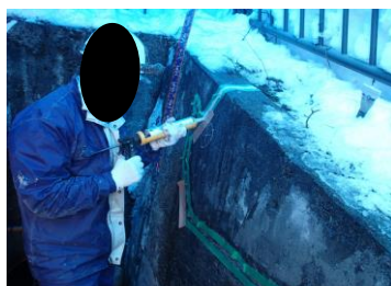
【補修材の充てん状況】
