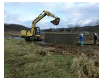
【敷鉄板設置状況】
