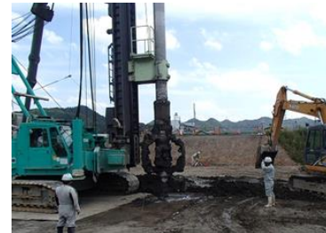
【貫入攪拌状況】
