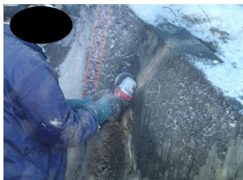
【ひび割れ面のカット状況】
