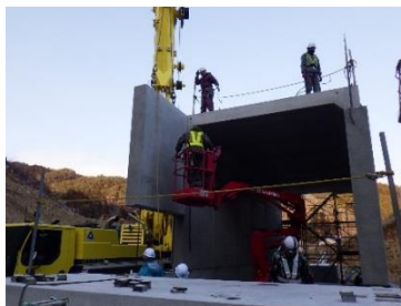
【大型ボックスカルバート接続状況】
