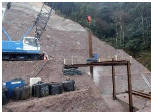
【テーブルマシン工法による削孔状況】
