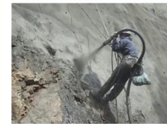
仮設用モルタル吹付状況
