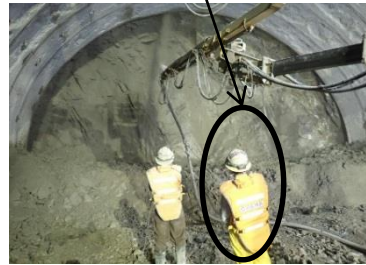
【切羽監視責任者の配置状況】
