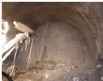
【鏡吹付施工状況】
