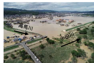
合流部の堤防決壊により、湛水深が深く甚大な被害が発生 (岡山県倉敷市真備町)
