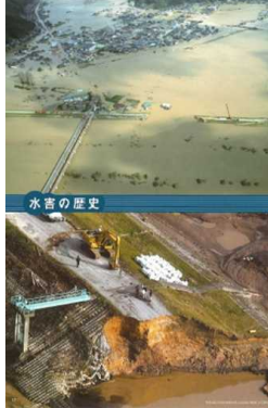
平成16年台風23号による浸水被害
