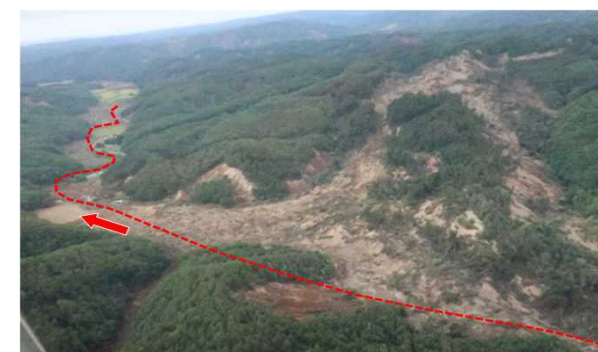
【山腹崩壊に伴う河道閉塞の状況】 (北海道勇払郡厚真町)
