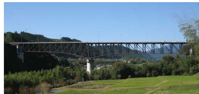
<乙姫大橋の状況>
