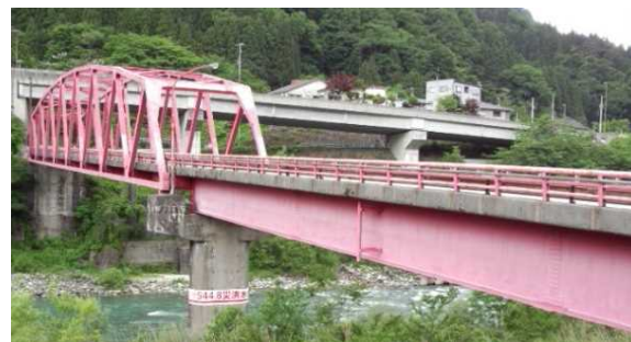
<音沢橋の状況>
