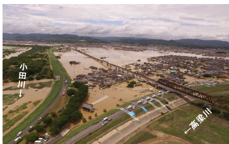
【平成30年7月豪雨による河川氾濫】(岡山県倉敷市真備町)
