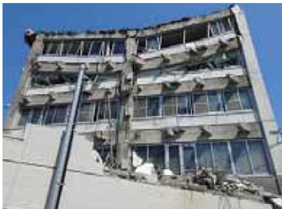
【旧耐震基準の建築物の被害】
