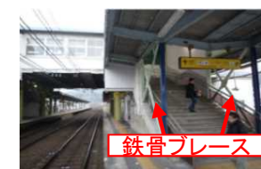
鉄骨ブレースによる駅の耐震補強
