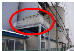
電気系設備の嵩上げ
