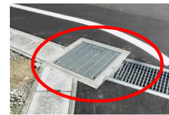
道路上の排水施設
