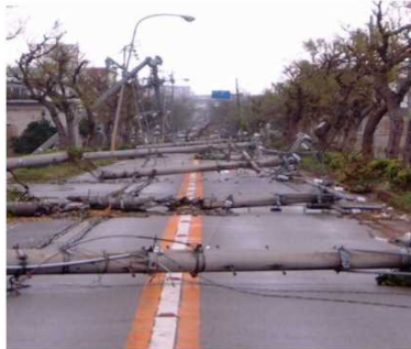
<電柱の倒壊による道路閉塞>
