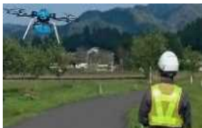
開発したレーザードローンで堤防を3次元測量
