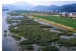
河川管理者による治水対策と併せた湿地整備
