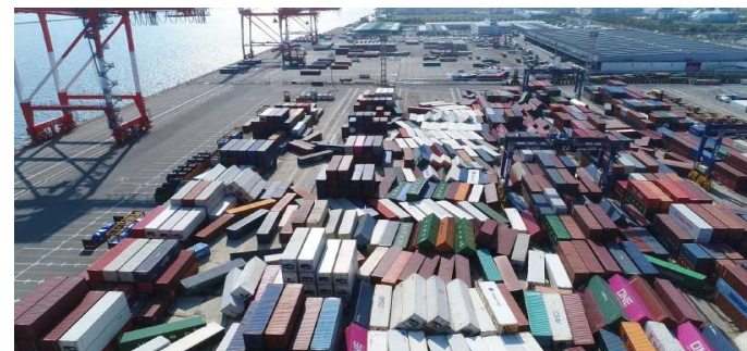
神戸港六甲アイランドの被災状況
