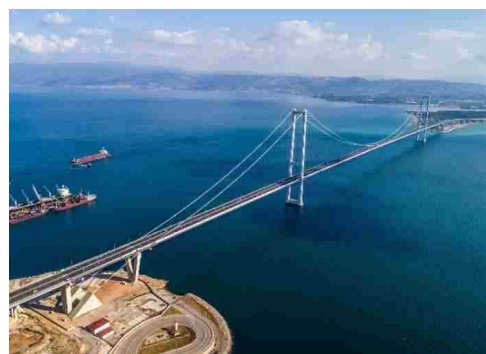
オスマン・ガーズィー橋の全景 (IHI提供)
