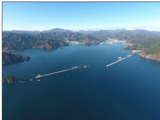
H29.12 釜石港湾口防波堤全景
