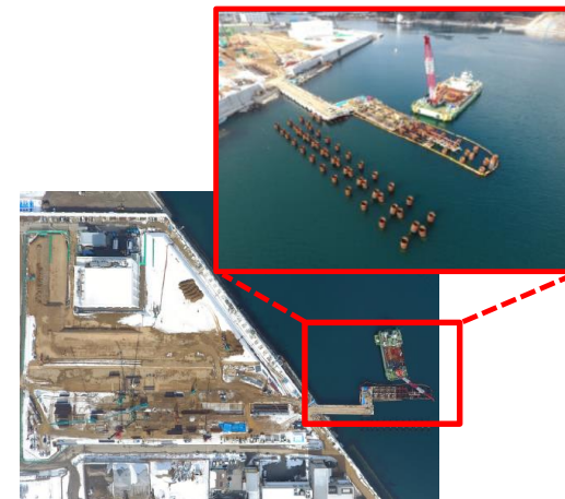
建造中の造船工場(H30.2現在)
