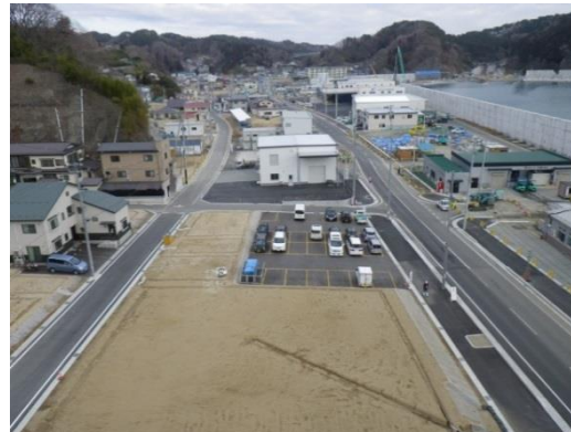
地区の状況(H29.12撮影)
