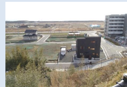
地区の状況(H29.12撮影)
