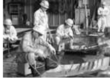
ぎょう鉄(鉄板曲げ加工)
