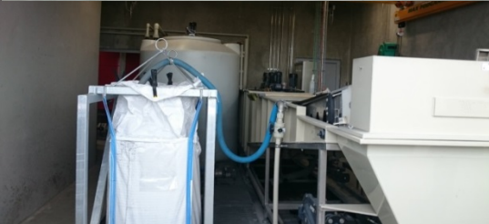
潜熱回収熱交換機
