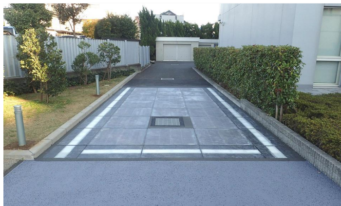
写真-1 開発を進めている太陽光発電舗装「e-Smart ROAD」
