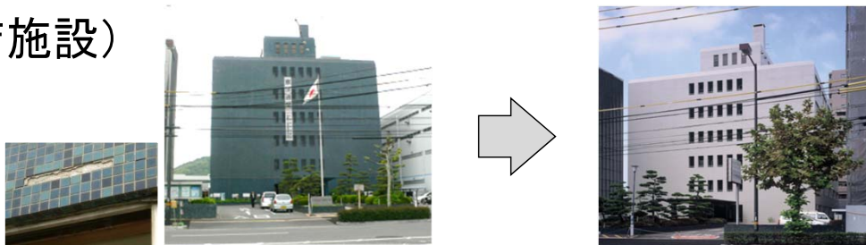
外壁改修による躯体の保護の例
