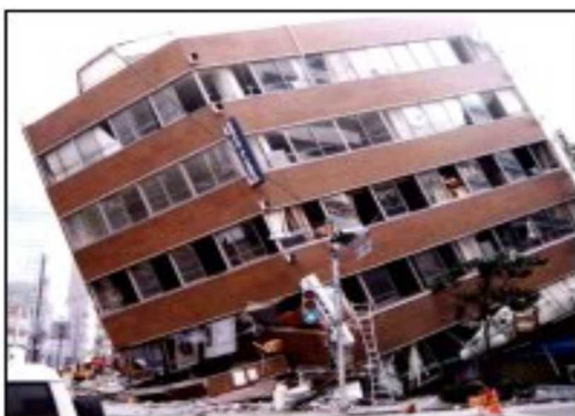
事務所ビル1, 2階の崩壊
