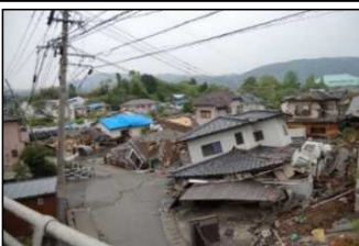
地震による被災状況 (熊本県益城町)
