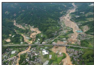
土砂による被災状況 (福岡県朝倉市)
