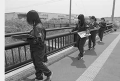
高校生による橋梁の日常点検
