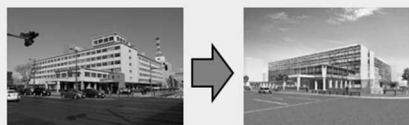
<改修前/7階建庁舎> <改修後/6階建庁舎> 効率的利用等の一例 庁舎の減築・耐震化
