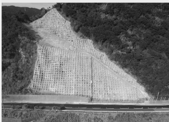
法面対策による交通 ネットワークの確保(道路)
