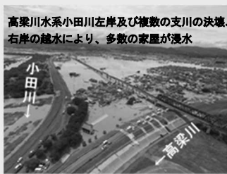
高梁川水系小田川左岸及び複数の支川の決壊、 右岸の越水により、多数の家屋が浸水 小田川 高梁川
