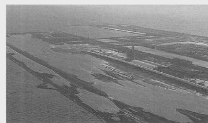
関西国際空港の被災状況 (台風第21号)
