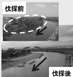
伐採前 伐採後 河道掘削・樹木伐採による 安全・安心の向上(河川)
