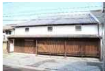
修理事業後の町屋
