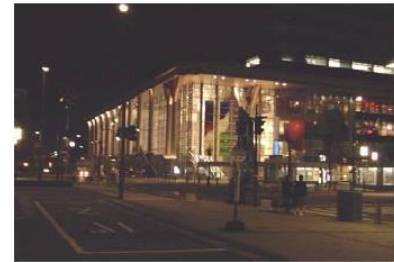
建築物から漏れる光により夜間景観を演出した例
