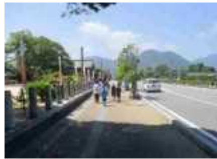
整備後の都市計画道路
