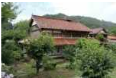
空き家となった従前の歴史的建造物
