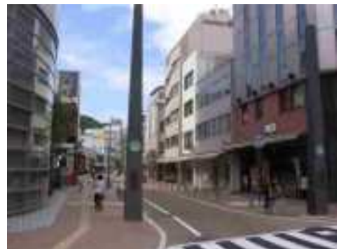
アーケードの撤去・オープンモール化
