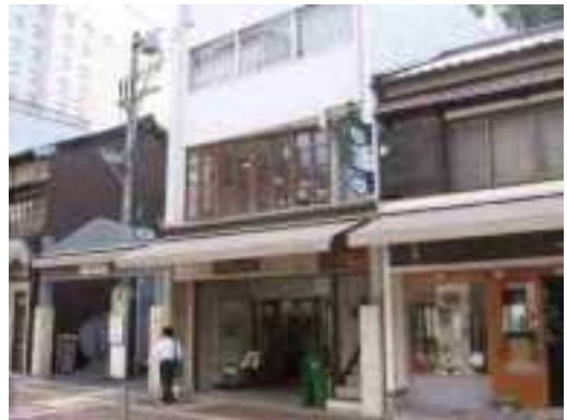
ファサード整備後
