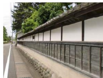
伝統的な意匠を取り入れて景観に配慮した塀の例
