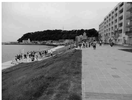
石巻市中央地区再開発事業及び 河川堤防の整備状況（平成 30 年 6 月）
