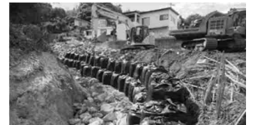
応急対策工事（流路確保）の実施（広島県広島市）
