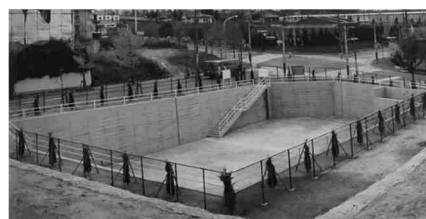
小規模な雨水貯留浸透施設の例
