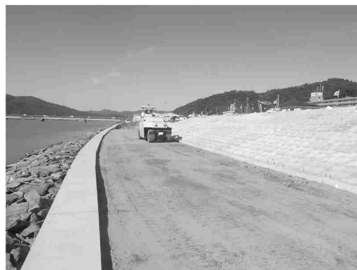
石巻市不動町地区の整備状況 （平成 30 年 6 月）
