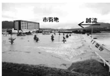
越水による浸水被害 愛媛県大洲市
