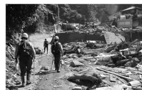
土砂災害箇所の被災状況調査 【広島県広島市】
