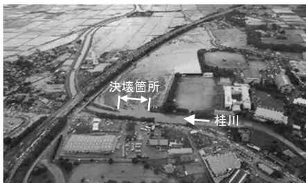
桂川沿川の浸水被害（福岡県朝倉市）
