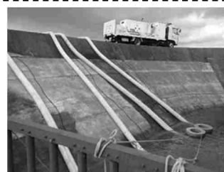
移動式排水施設による排水
