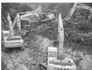
無人化施工の高度化例
