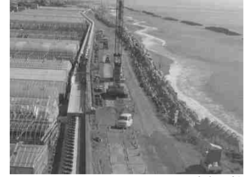
海岸堤防の耐震化(高知県南国市)
