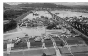
全国から排水ポンプ車23台が 集結し24時間体制で排水 【岡山県倉敷市真備町】
