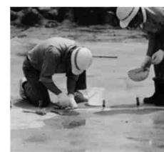
クラック補修状況 (注入工)
