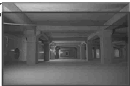
大州雨水貯留池
