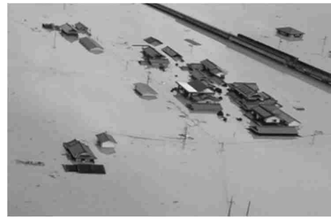
2階まで達した浸水 くらしきしまひらよう 【岡山県倉敷市真備町】
