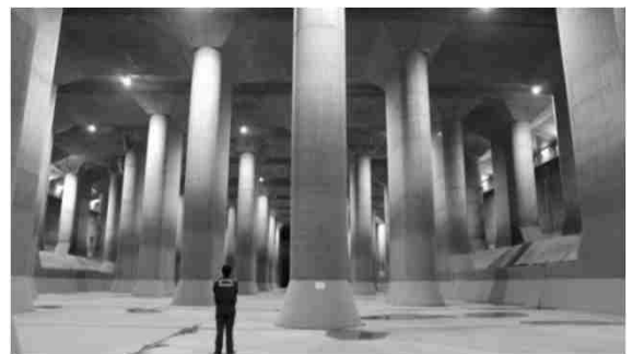
首都圏外郭放水路（埼玉県）
