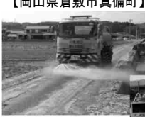
散水車による防塵対策 【岡山県倉敷市真備町】
