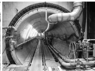
雨水貯留管の整備
