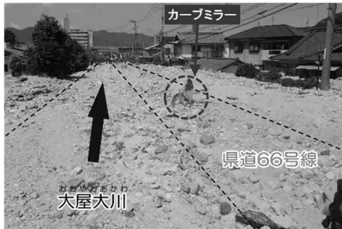
河道への土砂流入による土砂・洪水氾濫 くらしきしまひらよう 【広島県呉市】
