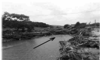
河川の浚渫 みはらし 【広島県三原市】
