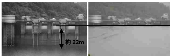
洪水貯留前のダム貯水池の状況 (7 月 5 日 8 時頃)
