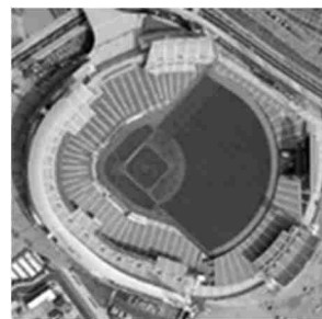
大州雨水貯留池の上部（広島市民球場）
