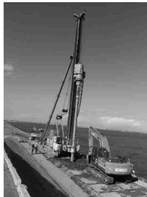
河川堤防における地震・津波対策 (三重県桑名市長島町)
