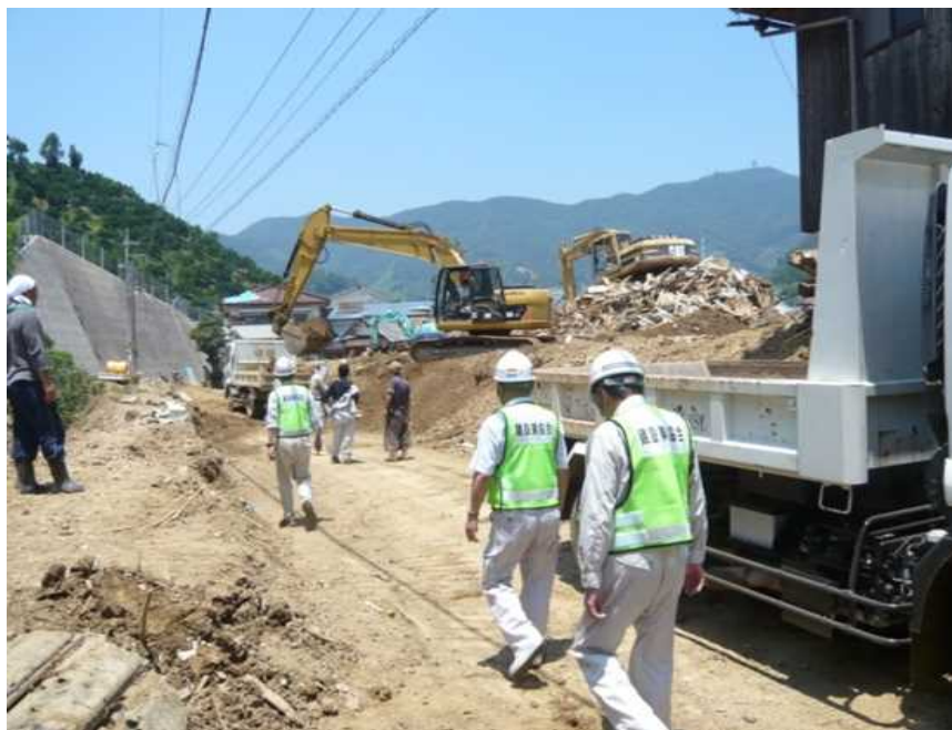
(一社)愛媛県建設業協会
