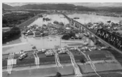
排水ポンプ車による排水状況 岡山県倉敷市真備町 くらしきしまびちょう
