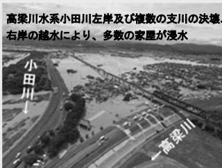
小田川における浸水状況 (平成30年7月豪雨)
