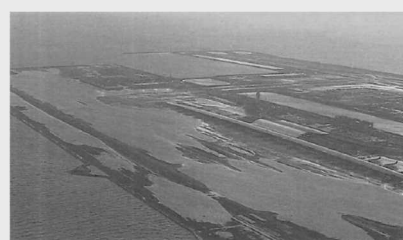
関西国際空港の被災状況 (台風第21号)
