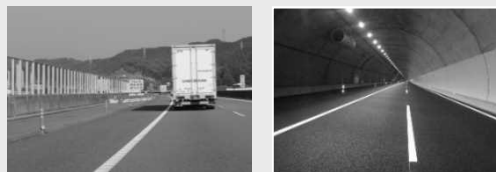
現況写真 (構造物 6 車線対応区間)
