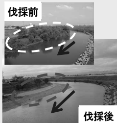
河道掘削・樹木伐採による 安全・安心の向上(河川)
