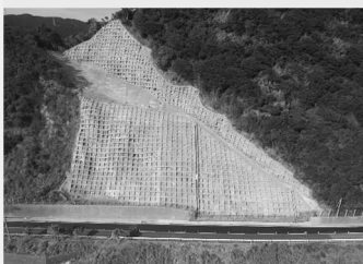
法面対策による交通 ネットワークの確保(道路)
