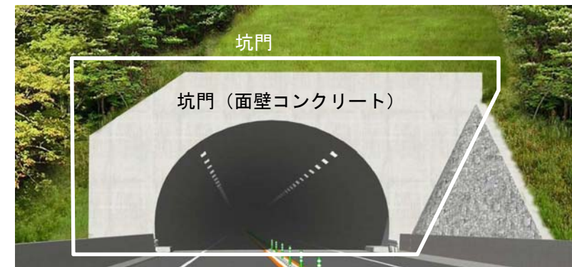
別図-1.2 点検対象箇所（トンネル坑口部）
