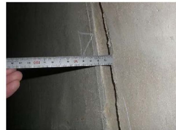
付図-2.4.5 目地部、打ち継目部の段差の例
