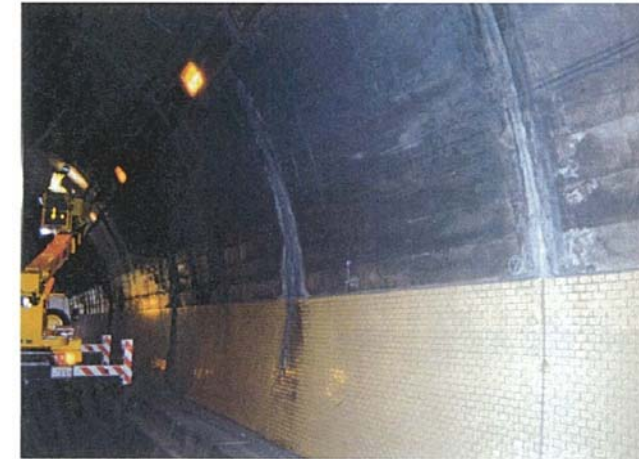
付図-2.3.1 覆工スパンの中間付近に発生する変状の例
