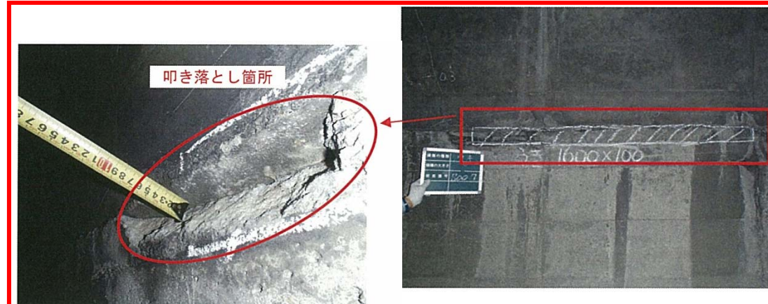
付写真-2.1.2 逆巻き工法の縦断方向打ち継目と化粧モルタルの施工状況の例
