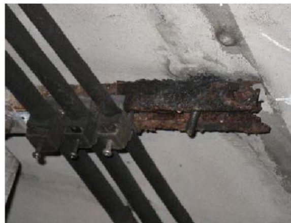
付写真-1.5.1 固定金具の腐食とアンカーボルトの脱落の例
