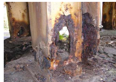
腐食片を取り除いた状態の例（下部）
