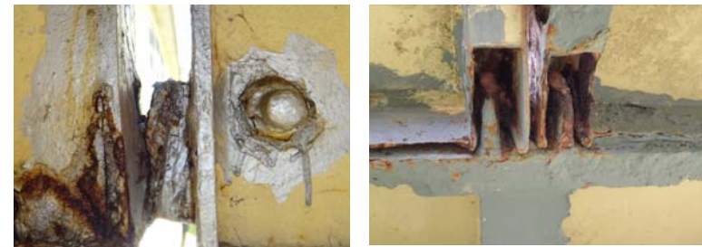
溶接の状態 (接合部)
