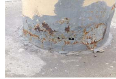
腐食片を取り除いた状態の例（下部）
