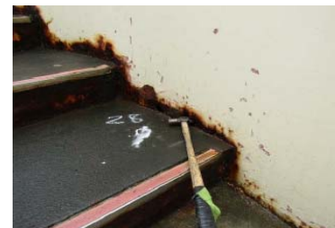
腐食片を取り除いた状態の例（階段部）
