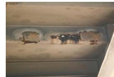
腐食片を取り除いた状態の例（階段部）
