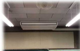
小学校全42校への 空調設備一斉導入
